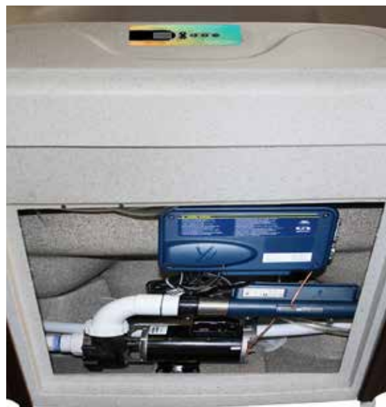
Le panneau d'accès à l'équipement est situé en dessous du panneau de commandes supérieur sur la plupart des spas.
